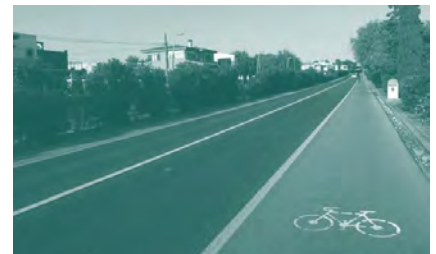
Foto 28. ACTUACIÓN 5. Carretera Ma-13A con arcones amplios destinados a los ciclistas.
