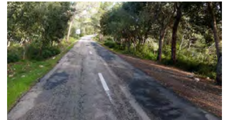
Foto 73. ACTUACIÓ 39. Carretera Ma-10 (tram del coll d'en Claret - Ma-1100).
