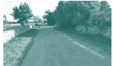
Foto 25. ACTUACIÓN 3. Tramo de la antigua carretera de Valldemossa.
