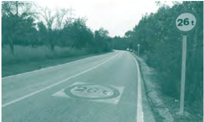
Foto 74. ACTUACIÓN 40. Carretera Ma-1041 entre la carretera de Calvià y la carretera de Establiments.
