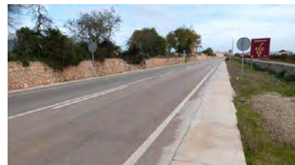
Foto 68. ACTUACIÓ 35. Anivellament de cunetes al tram Consell-Binissalem de l'Ma-13A.
