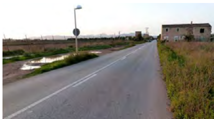
Foto 39. ACTUACIÓ 10. Carretera Ma-5013 entre Sant Jordi i sa Casa Blanca. S'hi aprecia la manca de voreres.
