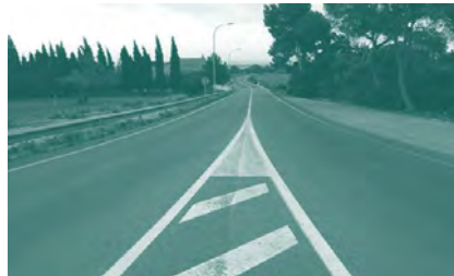
Foto 52. ACTUACIÓN 22. Carretera Felanitx - Portocolom (Ma-4010).
