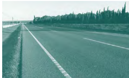
Foto 38. ACTUACIÓN 9. Carretera Ma-3011 (tramo Ma-3017 - Santa Eugènia) con arcenes estrechos.
