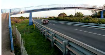
Foto 36. ACTUACIÓ 8. Pas elevat sobre l'autopista Ma-19.
