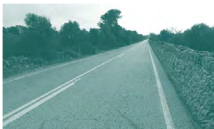
Foto 43. ACTUACIÓN 14. Carretera Llucmajor - S'Estanyol (Ma-6015).
