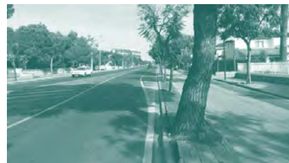
Foto 60. ACTUACIÓN 29. Carretera Ma-12, en la travesía urbana de la Platja d'Alcúdia.
