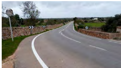
Foto 47. ACTUACIÓ 18. Carretera ses Salines - Colònia de Sant Jordi (Ma-6100).
