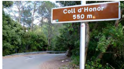
Foto 71. ACTUACIÓ 37. Es necessita una millora del ferm de la carretera Ma-2100, especialment al coll d'Honor.
