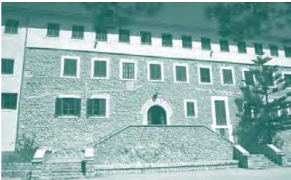
Foto 77. Ermita de Santa Lúcia (Mancor de la Vall).
