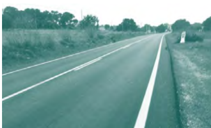
Foto 46. ACTUACIÓN 17. Carretera Campos - Colònia de Sant Jordi (Ma-6040).
