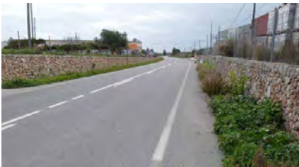
Foto 45. ACTUACIÓ 16. Carretera Porreres-Campos (Ma-5040).
