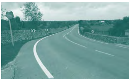
Foto 47. ACTUACIÓN 18. Carretera Ses Salines - Colònia de Sant Jordi (Ma-6100).
