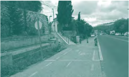
Foto 72. ACTUACIÓN 38. Carretera Ma-11 Sóller - Port de Sóller (enlace con el carril bici de Son Angelsats).
