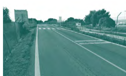
Foto 34. ACTUACIÓN 8. Carretera del Aeropuerto - polígono de Son Oms (Camí de Son Fangos).
