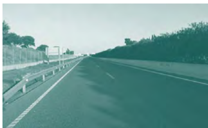
Foto 31. ACTUACIÓN 6. Carretera Ma-15D (tramo Palma - Ma-30) con cuatro carriles y arcones estrechos.
