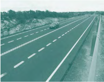
Foto 18. La carretera Ma-4020 entre Manacor y Porto Cristo es un ejemplo de vía no recomendada.
