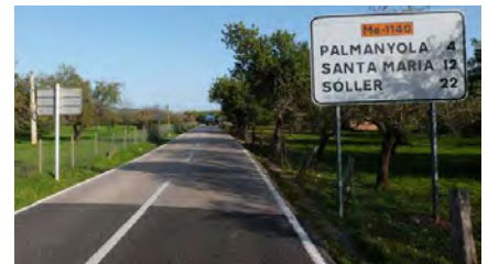
Foto 26. ACTUACIÓ 4. Carretera Ma-1140 (de s'Esgleietà a Ma-11). S'hi aprecia la manca de voreres.
