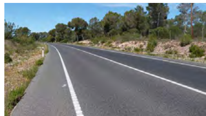
Foto 44. ACTUACIÓ 15. Carretera Lluçmajor-Campos (Ma-19).
