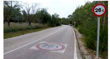
Foto 74. ACTUACIÓ 40. Carretera Ma-1041 entre la carretera de Calvià i la carretera d'Establiments.
