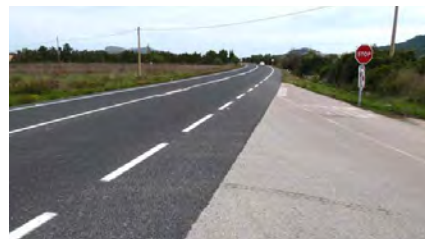
Foto 55. ACTUACIÓ 25. Carretera Ma-15 (tram molí Vell - polígon industrial de Capdepera).
