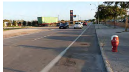
Foto 32. ACTUACIÓ 7. Carretera Ma-19A (tram Coll d'en Rabassa - Can Pastilla).
