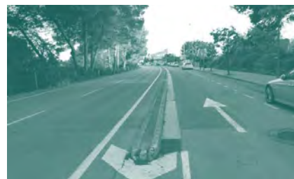
Foto 33. ACTUACIÓN 7. Carretera Ma-19A (tramo Coll d'en Rabassa - Can Pastilla).
