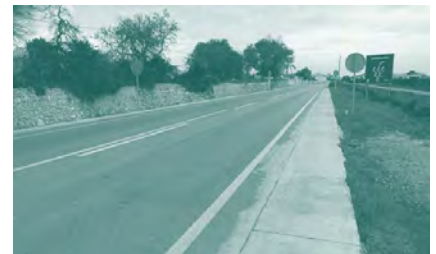
Foto 68. ACTUACIÓN 35. Nivelación de cunetas en el tramo Consell-Biniissalem de la Ma-13A.
