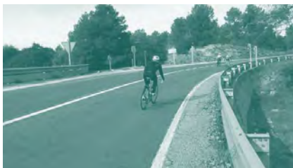
Foto 57. ACTUACIÓN 27. Carretera Ma-12 entre Can Picafort y la Colònia de Sant Pere.
