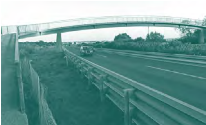
Foto 36. ACTUACIÓN 8. Paso elevado sobre la autopista Ma-19.
