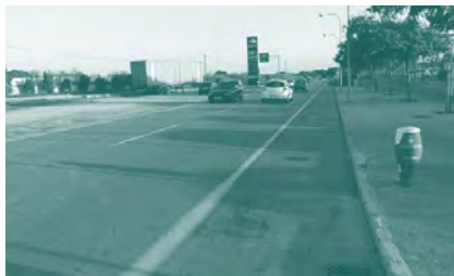
Foto 32. ACTUACIÓN 7. Carretera Ma-19A (tramo Coll d'en Rabassa - Can Pastilla).
