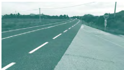
Foto 55. ACTUACIÓN 25. Carretera Ma-15 (tramo Molí Vell - polígono industrial de Capdepera).
