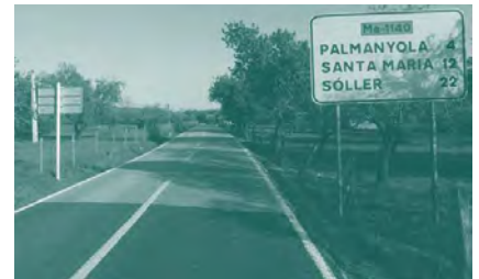
Foto 26. ACTUACIÓN 4. Carretera Ma-1140 (de S'Esgleietta a la Ma-11). Se aprecia la ausencia de arcones.
