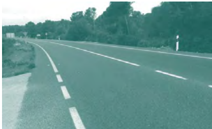
Foto 50. ACTUACIÓN 21. Carretera S'Alqueria Blanca - Portocolom (Ma-4012).
