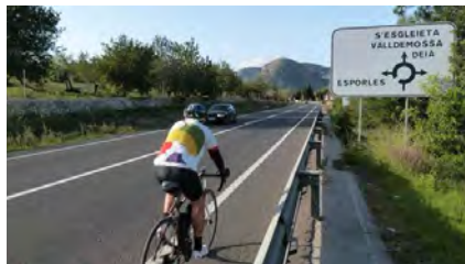
Foto 24. ACTUACIÓ 3. Carretera de Valldemossa (Ma-1110, tram entre UIB i s'Esgleietà)
