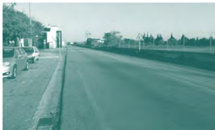
Foto 30. ACTUACIÓN 6. Carretera Ma-15D (tramo Ma-30 - Son Ferriol) con dos carriles y arcones estrechos.
