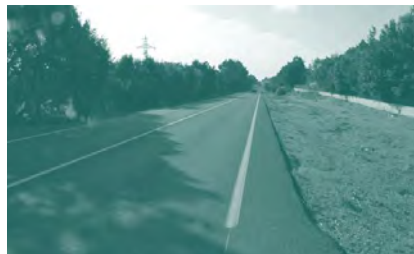
Foto 63. ACTUACIÓN 31. La carretera Ma-2200 tiene arcones estrechos, pero dispone de una amplia reserva viaria en la zona de Crestatx.
