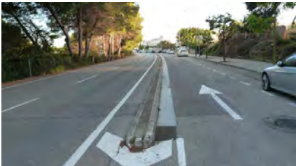
Foto 33. ACTUACIÓ 7. Carretera Ma-19A (tram Coll d'en Rabassa - Can Pastilla).
