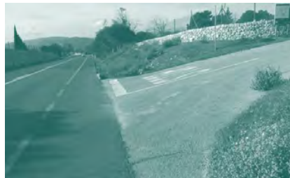
Foto 62. ACTUACIÓN 30. Cruce del Camí de Can Bregat y de la carretera Ma-13.
