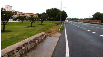
Foto 40. ACTUACIÓ 11. Carretera Ma-6014 entre Cala Blava i el cap Blanc. S'hi aprecien els amplis espais lliures públics de les urbanitzacions.
