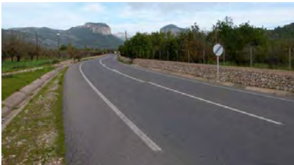
Foto 69. ACTUACIÓ 36. Carretera Ma-2022 entre Alaró i el desviament de l'estació del tren.
