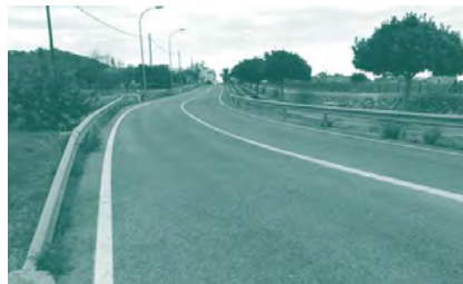
Foto 51. ACTUACIÓN 21. Carretera S'Alqueria Blanca - Portocolom (Ma-4012).
