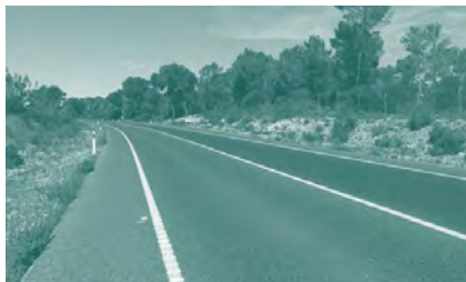
Foto 44. ACTUACIÓN 15. Carretera Llucmajor - Campos (Ma-19).
