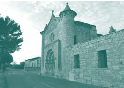
Foto 17. La carretera Ma-4021 entre Manacor y Son Carrió es un ejemplo de vía apta.
