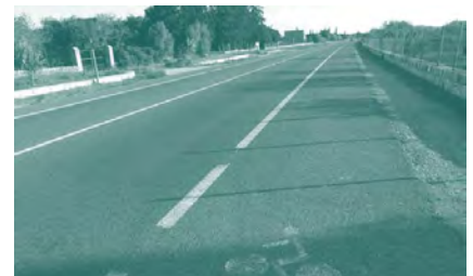
Foto 27. ACTUACIÓN 4. Carretera Ma-2040 con arcones amplios destinados a los ciclistas.
