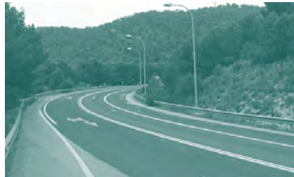
Foto 21. ACTUACIÓN 1. Carretera Ma-1 entre Peguera y Andratx.
