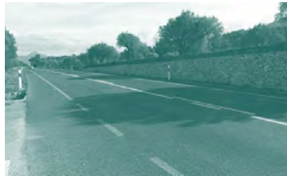
Foto 61. ACTUACIÓN 30. Carretera Ma-13 entre el Camí de Can Bregat y Alcúdia.
