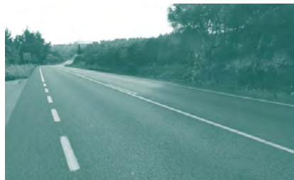
Foto 64. ACTUACIÓN 32. Carretera Ma-2200 entre el golf de Can Porquer y el Camí Vell de Campanet.
