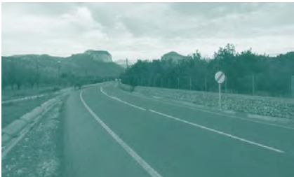
Foto 69. ACTUACIÓN 36. Carretera Ma-2022 entre Alaró y el desvío estación del tren.
