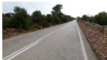
Foto 43. ACTUACIÓ 14. Carretera Lluçmajor - s'Estanyol (Ma-6015).
