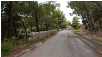
Foto 22. ACTUACIÓ 1. Tram de l'antiga carretera d'Andratx.
