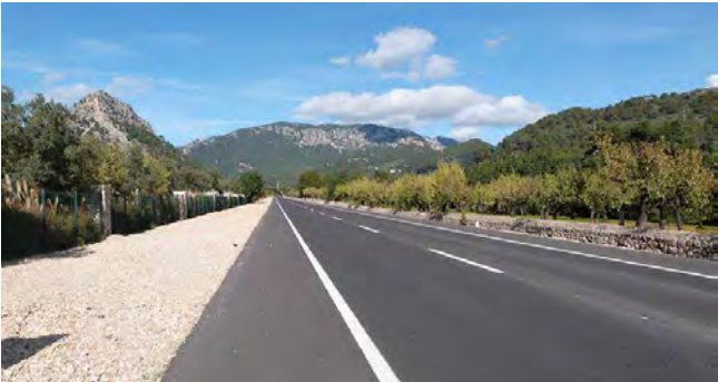
Foto 19. L'Ma-11 de Palma a Sóller és un exemple de carretera amb vorera ampla.
