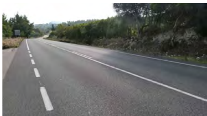
Foto 64. ACTUACIÓ 32. Carretera Ma-2200 entre el golf de Can Porquer i el camí Vell de Campanet.
