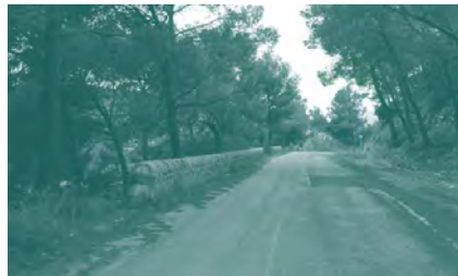
Foto 22. ACTUACIÓN 1. Tramo de la antigua carretera de Andratx.
