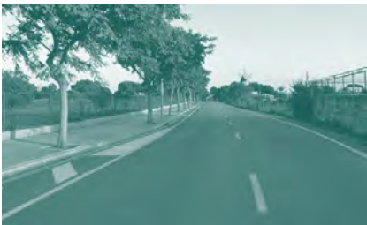
Foto 35. ACTUACIÓN 8. Carretera del Aeropuerto - polígono de Son Oms (Camí de Son Fangos).
