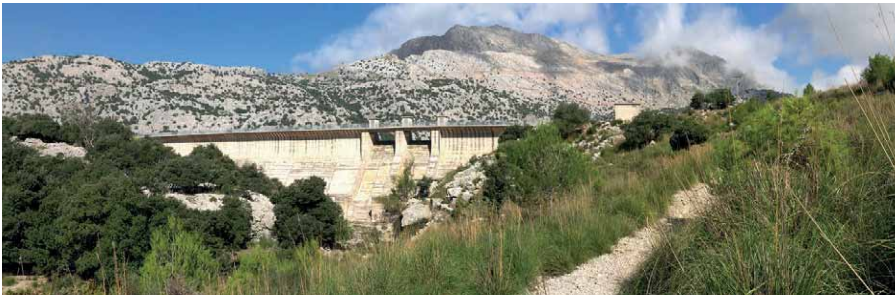
Presa de l'embassament de Cúber, 2018.
