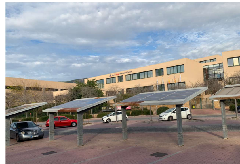
Ilustración 43. Pérgola fotovoltaica estacionamiento de al lado.
