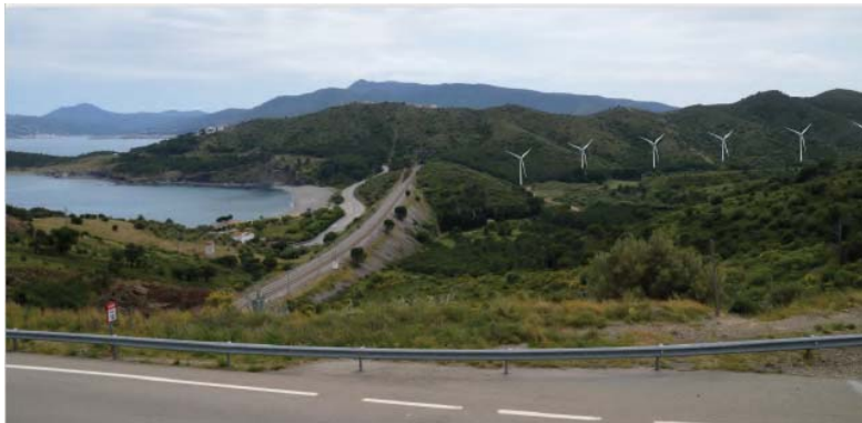
Aerogeneradors situats a les valls situades entre carenes
