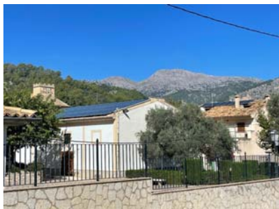
Exemple d'instal·lacions fotovoltaïques d'autoconsum a Mallorca
