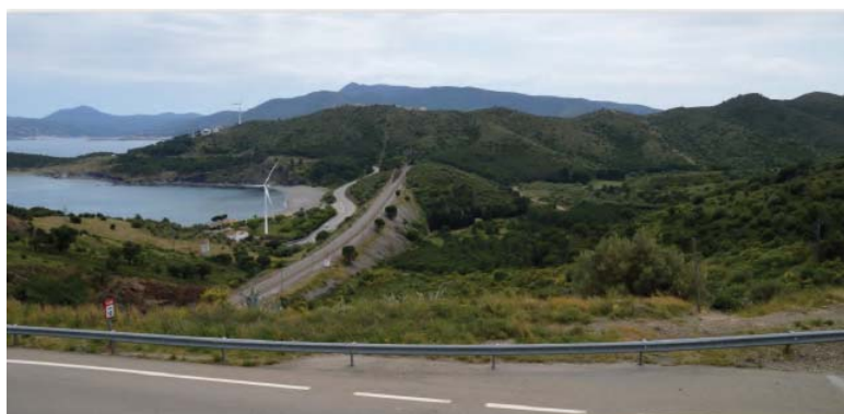
Aerogeneradors situats entre enclavaments concrets del litoral
