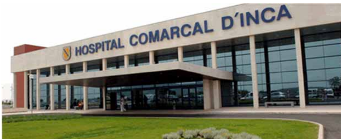
Imatge de la façana de l'HCI
