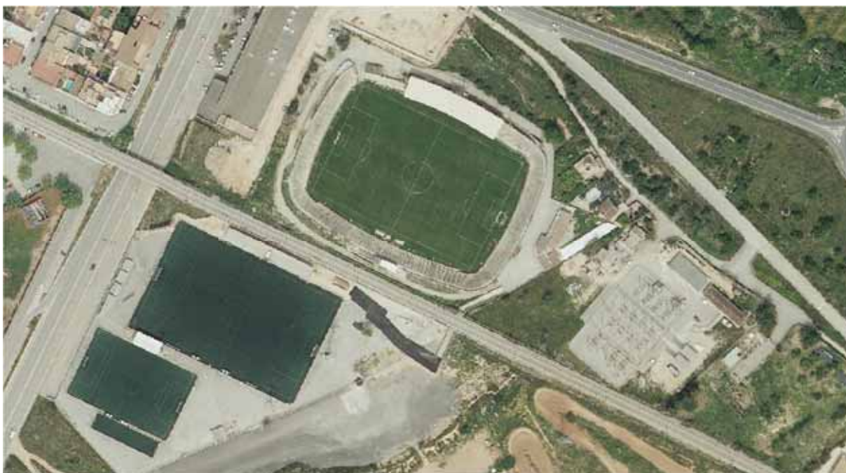
Ortofotografia de l'any 2018 amb les instal·lacions esportives
