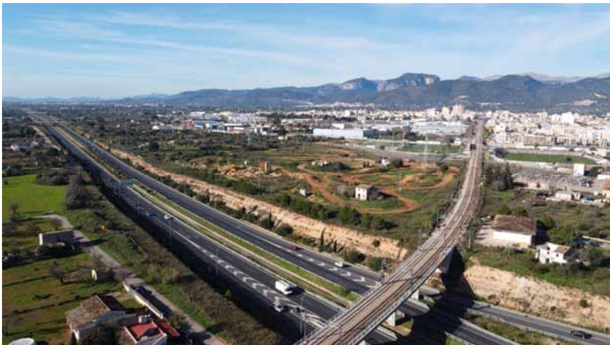
Imatge 14. Vista aèria de l'estat actual
