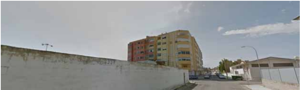
Imatge 49. Vista de l'edifici del carrer Mostassaf
