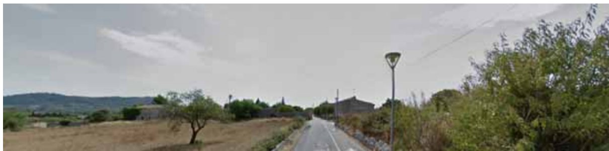
Imatge 44. Vista del carrer de Llubí cap a l'Hospital
