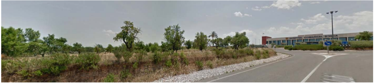
Imatge 56. Vista de la zona d'ampliació de l'Hospital.
