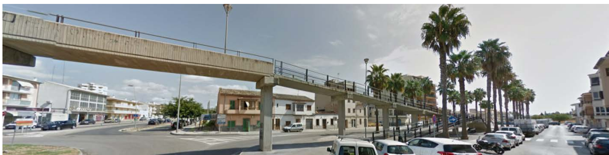
Imatge 65. Vista del pont de connexió de l'Av. de Reis Catòlics
