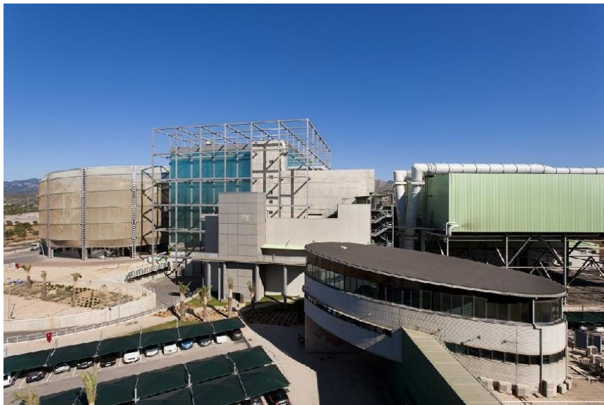
IL·LUSTRACIÓ 2. PLANTA DE VALORITZACIÓ ENERGÈTICA DE SON REUS
